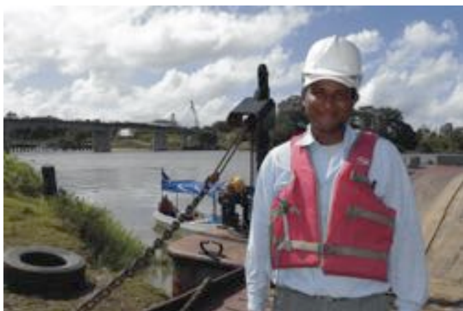
Arbeiter beim Brückenbau über den Rio San Juan
